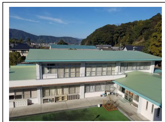
防水補修された屋根、屋上
